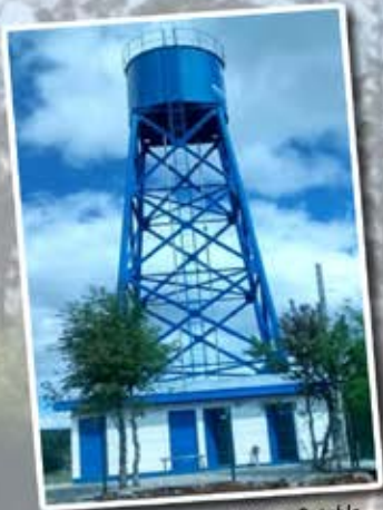
Construcción Sistema de Agua Potable Rural Huaqui, Comuna de Lanchoe, Región de La Araucanía”, Contrato CO-APR-1604-2015
